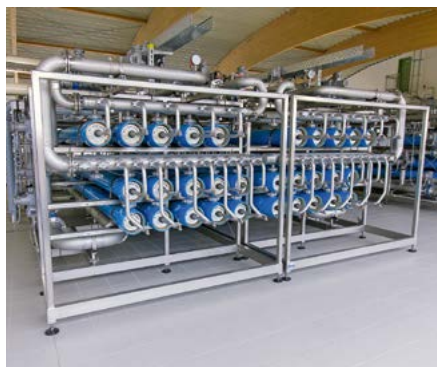
NF-Anlage zur Trinkwasseraufbereitung (Foto: Stadtwerke Dinslaken GmbH)
